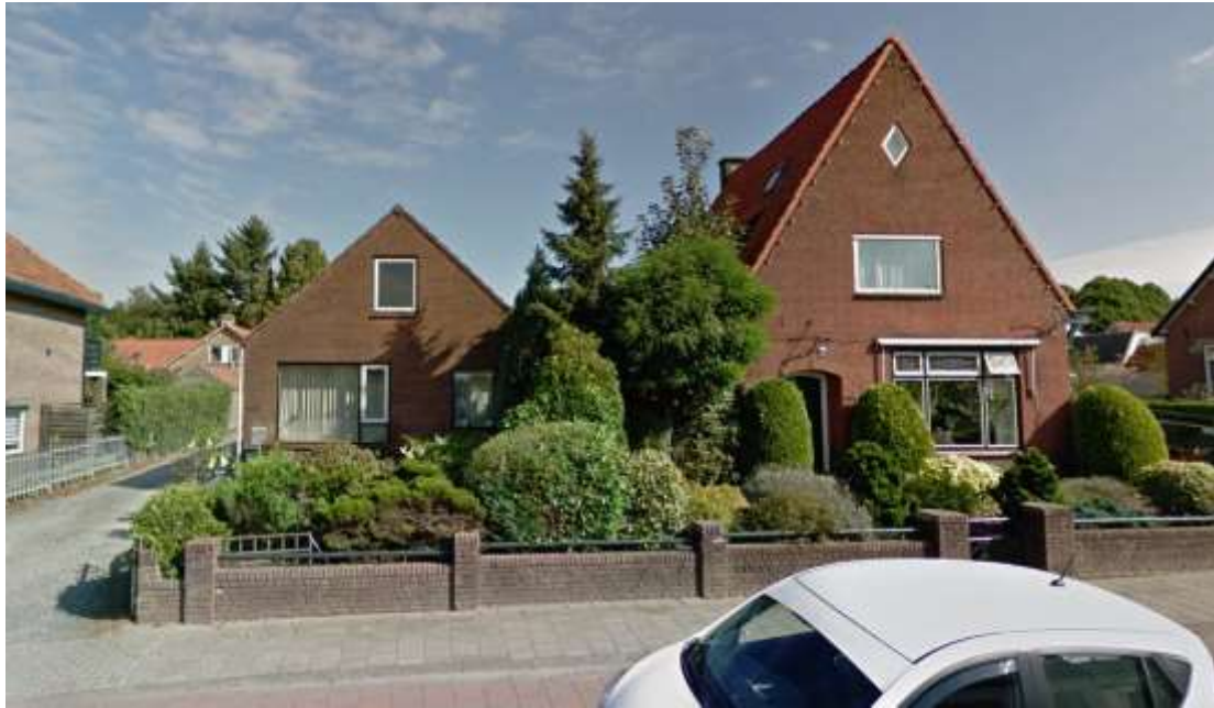
Woningen Rijksstraatweg 204 en 206 (Bron: Google Maps)
