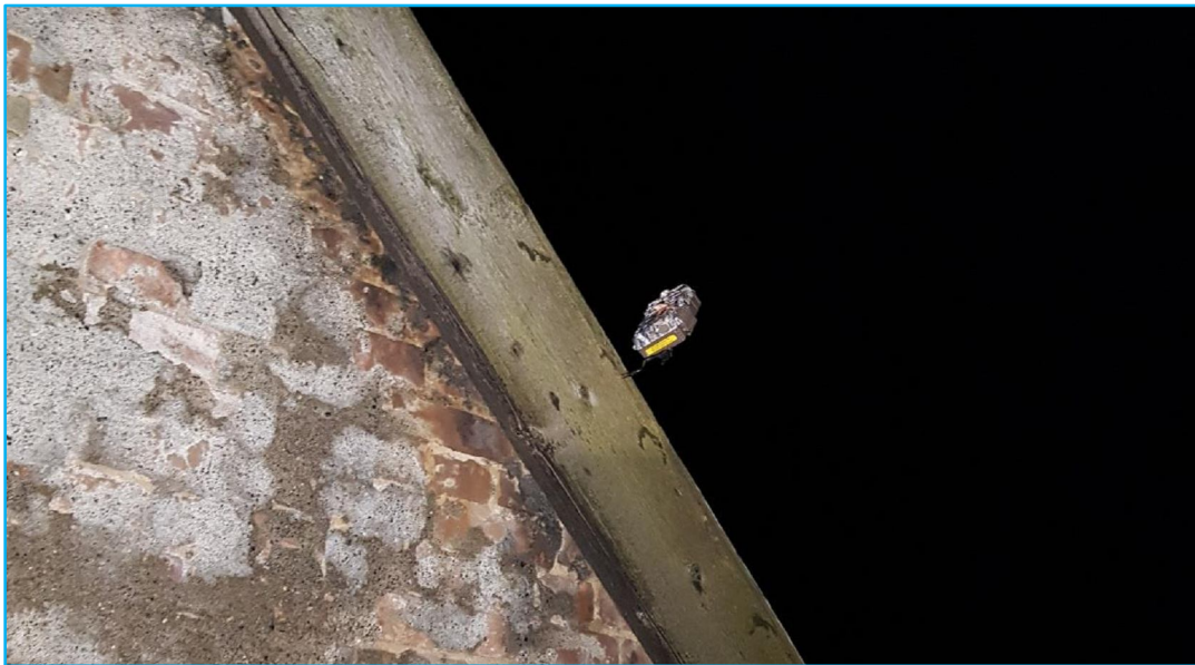
Foto: Cameraval gericht op de openingen in het dak.
