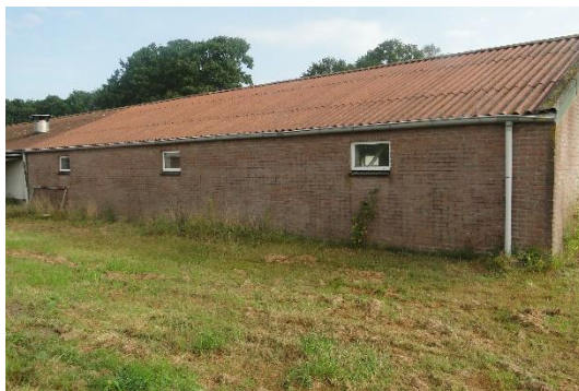
Figuur 4.1: Aanzicht zuidwestelijke schuur
