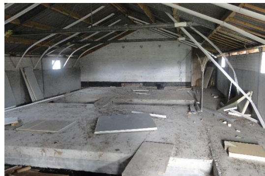
Figuur 4.2: Zuidwestelijke schuur
