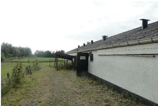
Noordgevel van de noordelijkste te slopen stal
