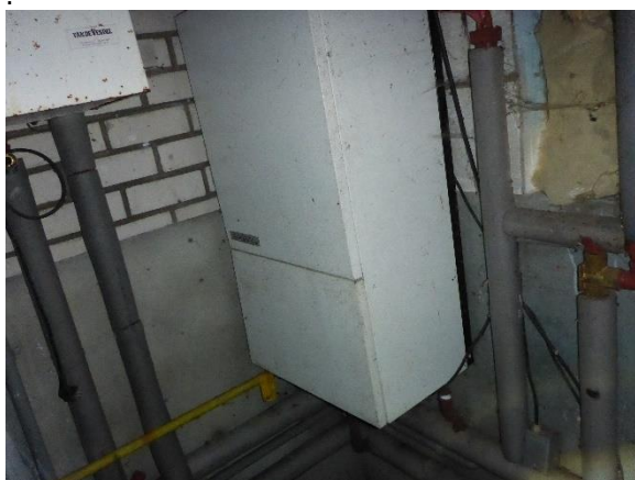
Foto 3: De aangetroffen ketels zijn (volgens Intechnum) niet asbestverdacht
