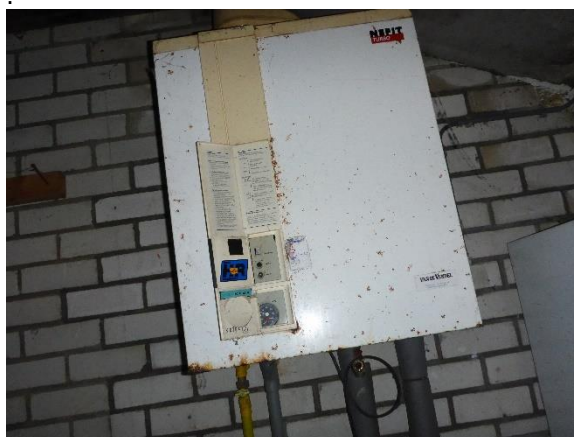
Foto 3: De aangetroffen ketels zijn (volgens Intechnum) niet asbestverdacht
