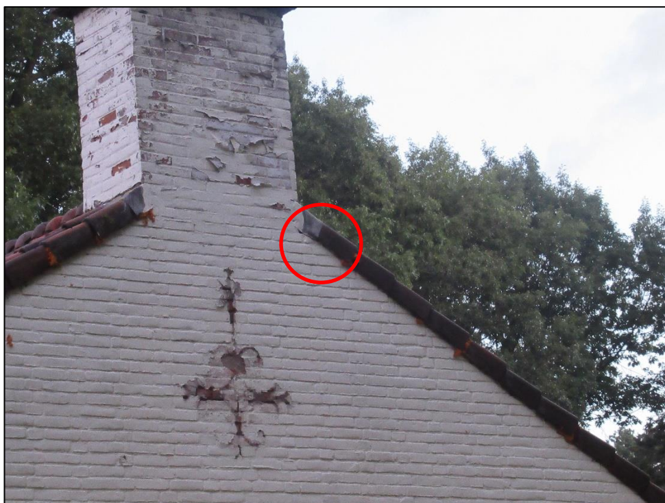
Afbeelding 3: : Zomerverblijfplaats aan de oostzijde van de bebouwing gelegen binnen het plangebied aan de Koningin Julianalaan 48 te Leersum (foto: Aveco de Bondt, 2019).
