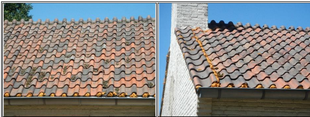
Afbeelding 5: Ruimtes onder de dakpannen met purschuim (Aveco de Bondt, 2018).
