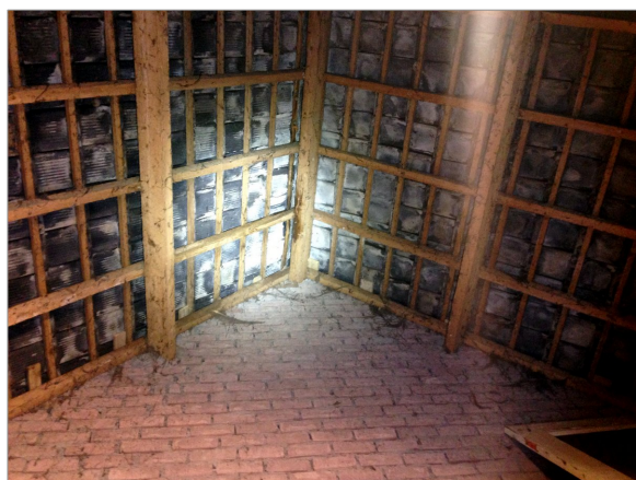
Figuur 4 | Detail binnenzijde kapconstructie.
