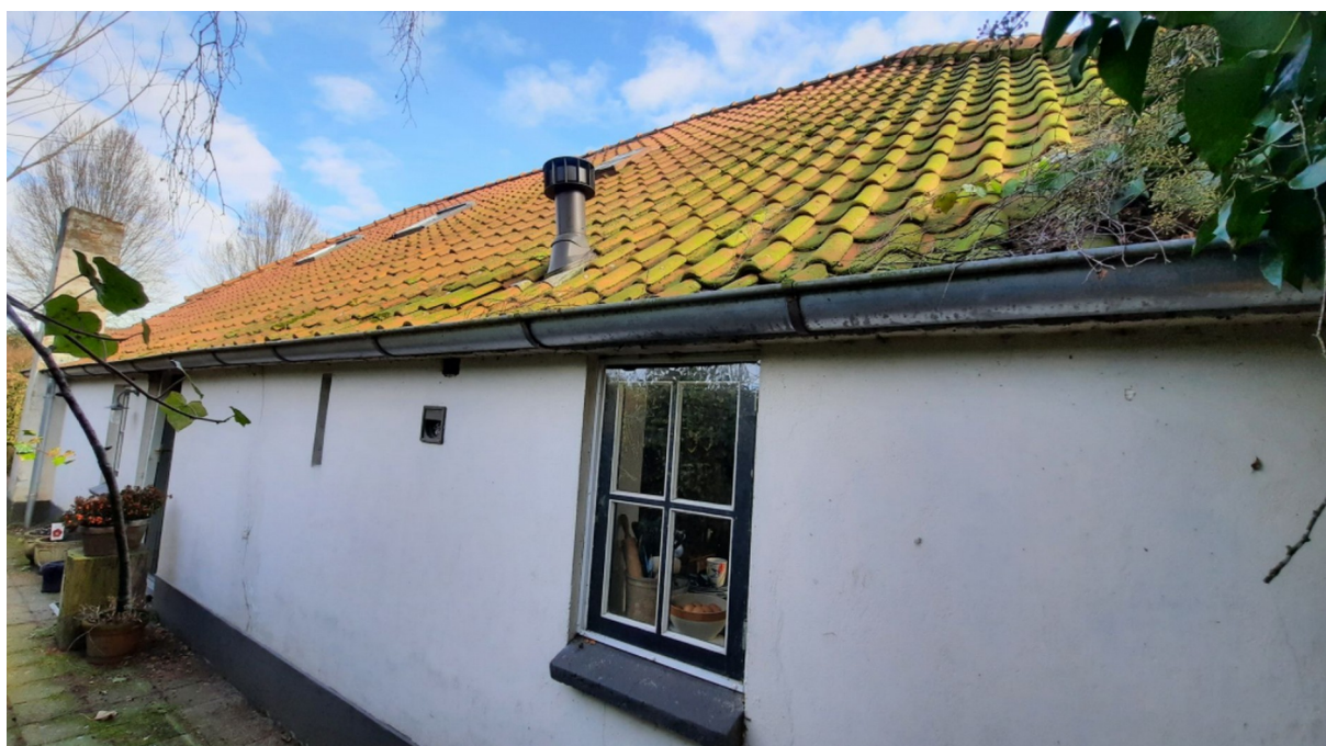
Westelijke gevel woonboerderij. Foto: B. Verhoeven / Ecoresult B.V.
