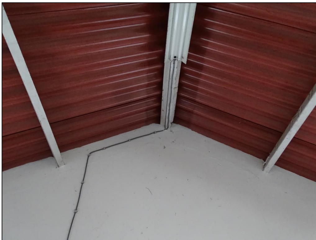
Figuur 2 Het dak van de schuur sluit nauw aan op de muren en bevat geen dakbeschot. Derhalve zijn er geen geschikte ruimten voor gebouwbewonende vleermuizen.
