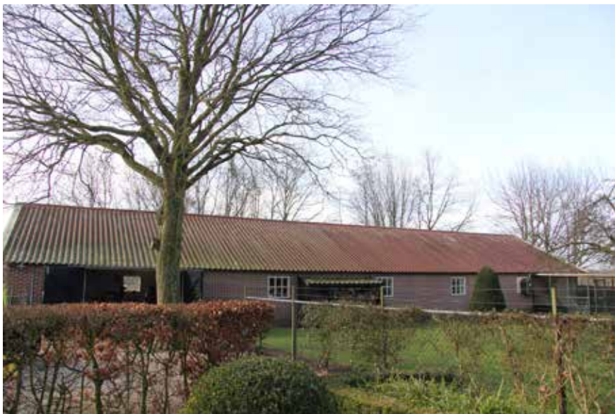
Zijgevel bestaande schuur / werkplaats
