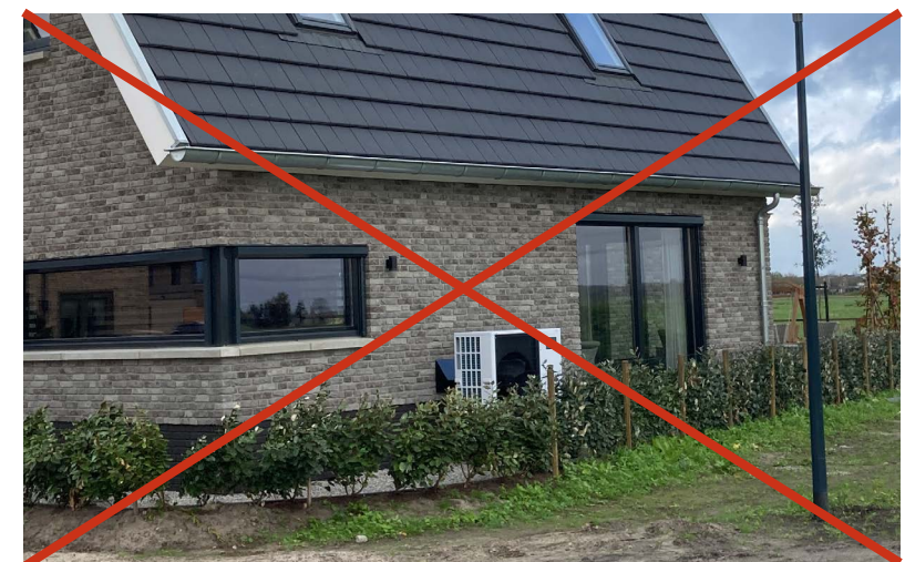
Warmtepomp te zichtbaar tegen gevel aan
