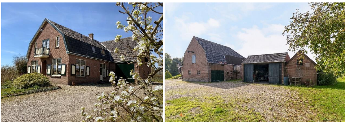
Figuur 3. De woning op Zandweg 6 met de voorzijde (links) en achterzijde (rechts) van het huis waar het pakhuis en de stenen schuur zichtbaar zijn. (Bron: Funda)
