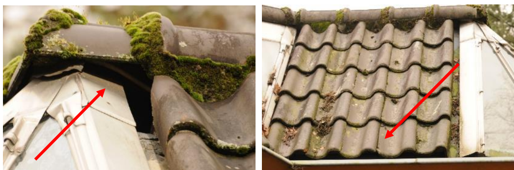
Figuur 3.6: Ruimtes onder de dakpannen geschikt voor huismus en gierzwaluw (foto's Laneco).
