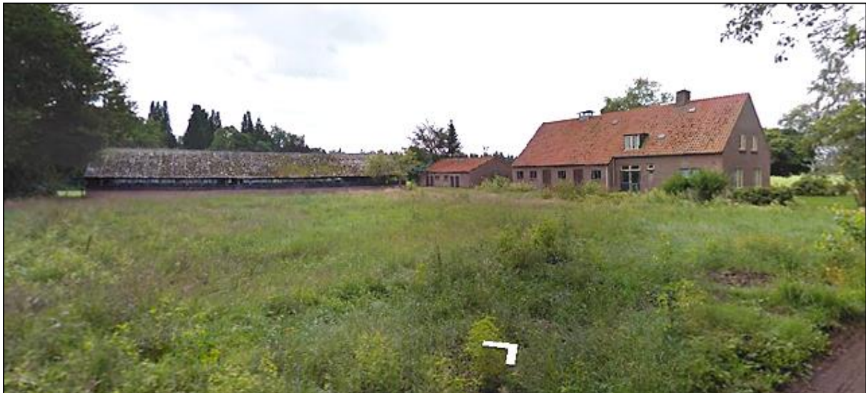
Afbeelding 1 Bestaande situatie. Rechts het hoofdgebouw met klein bijgebouw. Links het deels af te breken bijgebouw.
