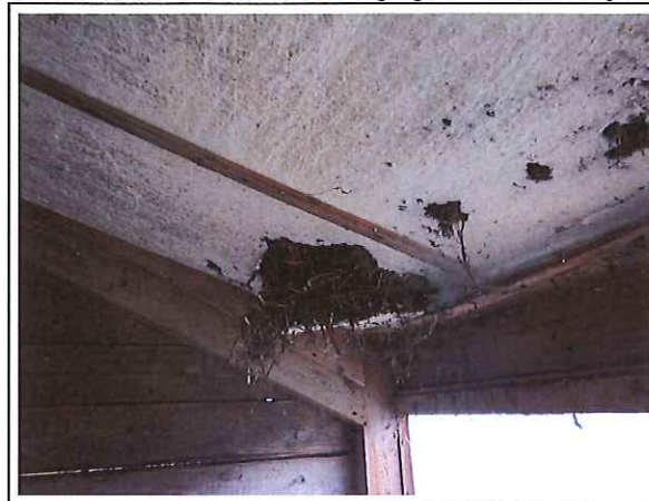
Foto 8: nestmateriaal onder de piepschuim isolatieplaten
