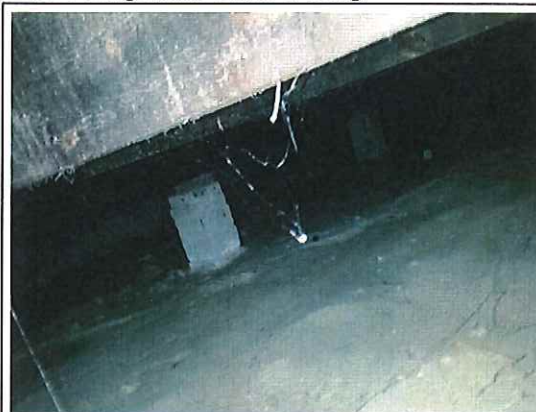
Foto 2: kruipruimte onder woning
