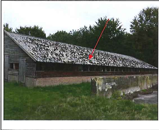
Foto 13: zuidoostzijde kippenschuur met daarop golfplaten als dakbedekking (item 4: M3)
