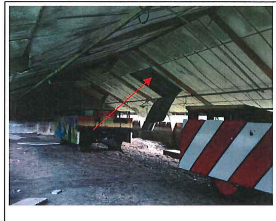
Foto 16: overzichtsfoto (voormalig) kippenverblijf met tempex dakbeschot
