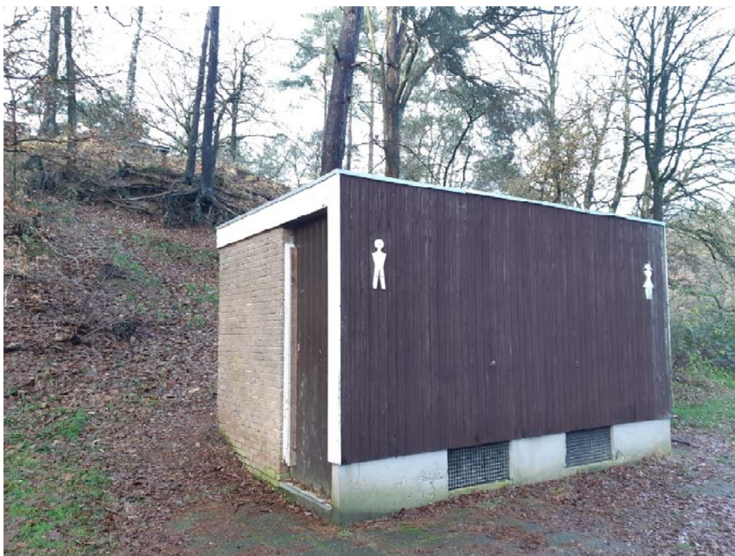
Foto 2 – Het toiletgebouw aan de voet van de centrale heuvel.
