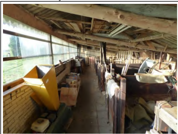
Foto 17: binnenzijde schuur d
