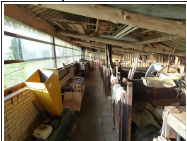
Foto 17: binnenzijde schuur d
