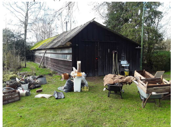
overzicht opstal A
