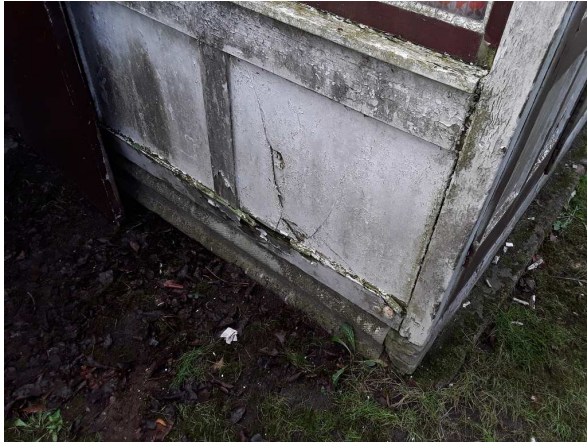
overzicht opstal B(6)
