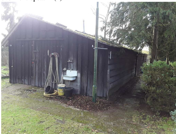
overzicht opstal A (2)
