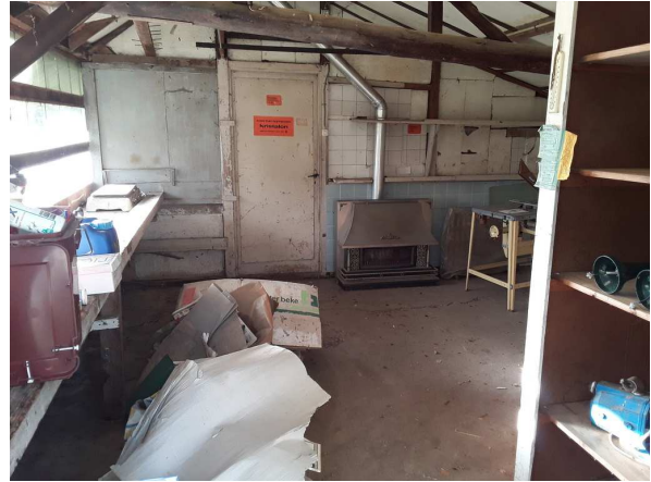
overzicht opstal A(3)
