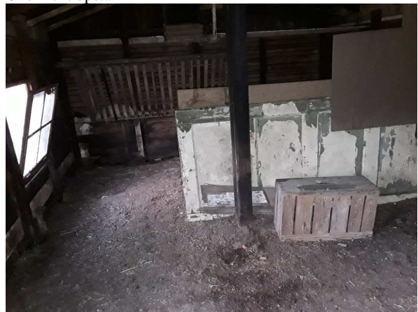
Overzicht opstal E (2)
