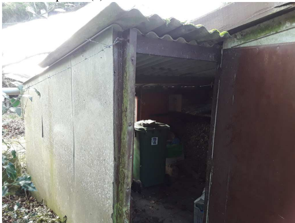
overzicht opstal B(4)
