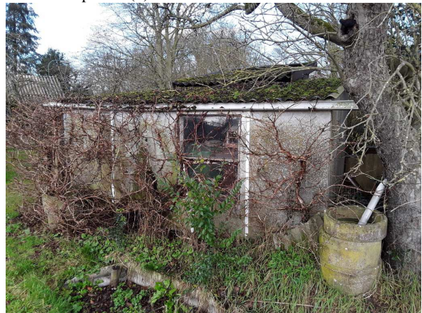
overzicht opstal B(3)
