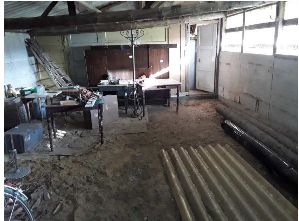
overzicht opstal A(8)
