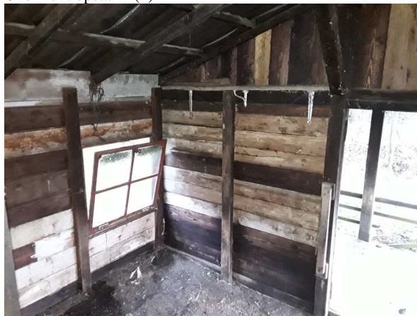
Overzicht opstal E (3)
