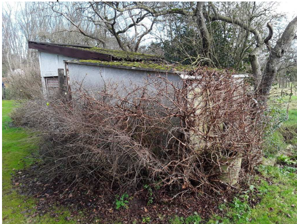
overzicht opstal B(2)
