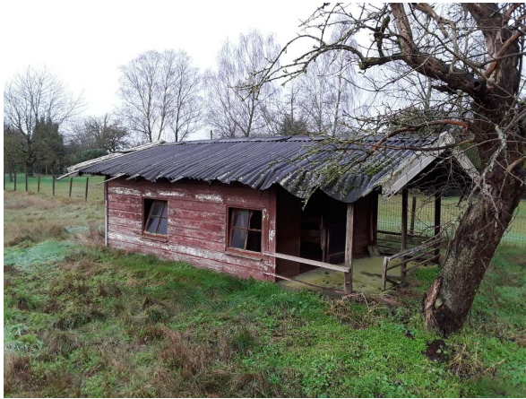
Overzicht opstal E
