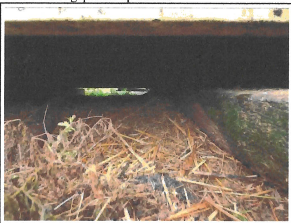
Foto 9: keet geplaatst op balken
