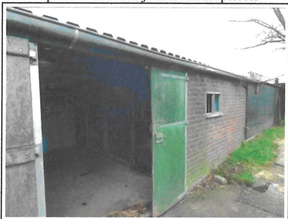
Foto 5: paardenstal zuidelijk deel van het perceel
