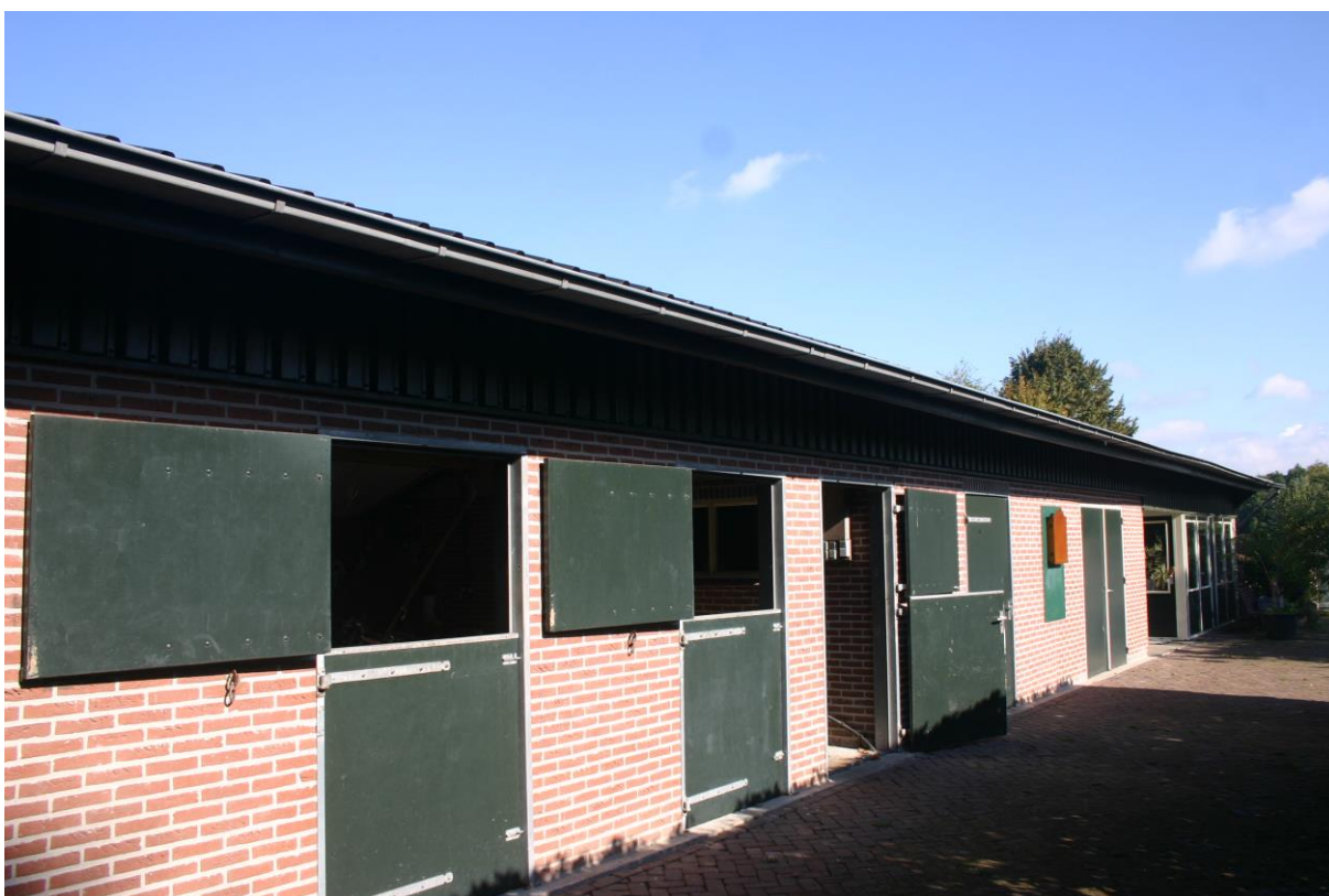
Figuur 3. Te slopen gebouw C.
