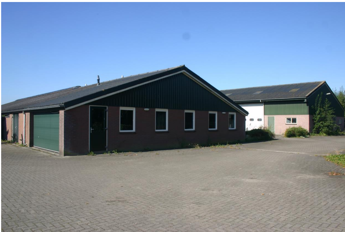
Figuur 2. De te slopen gebouwen A (op de voorgrond) en B (op de achtergrond).
