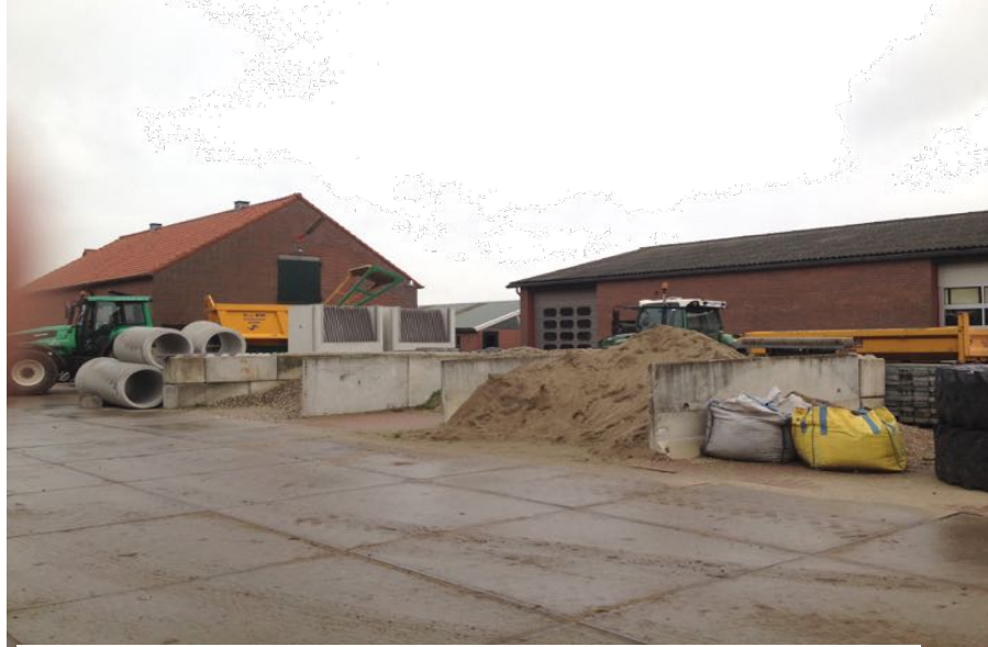
LINKS HET KANTOOR MET KANTINE EN FIETSEN- BERGING, AAN DE RECHTERZIJD DE WERKPLAATS
