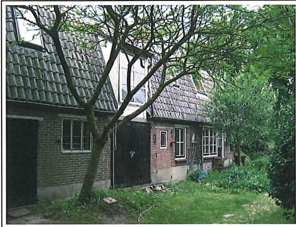
Foto 8: oostelijke deel woonhuis
