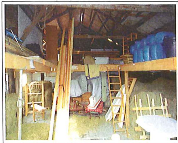
Foto 18: binnenzijde gebouw E
