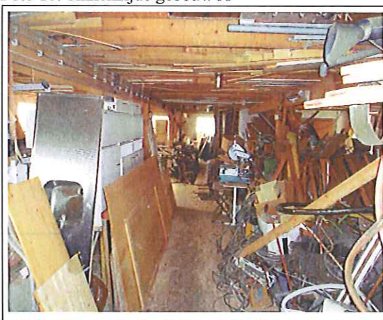
Foto 10: binnenzijde gebouw A
