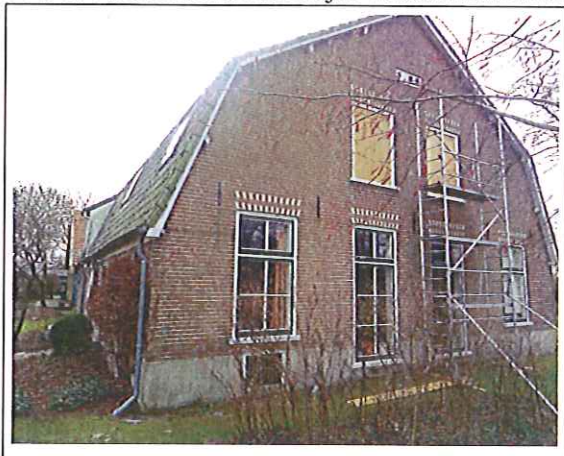
Foto 1: overzichtsfoto buitenzijde woonhuis nr. 11 en 11a
