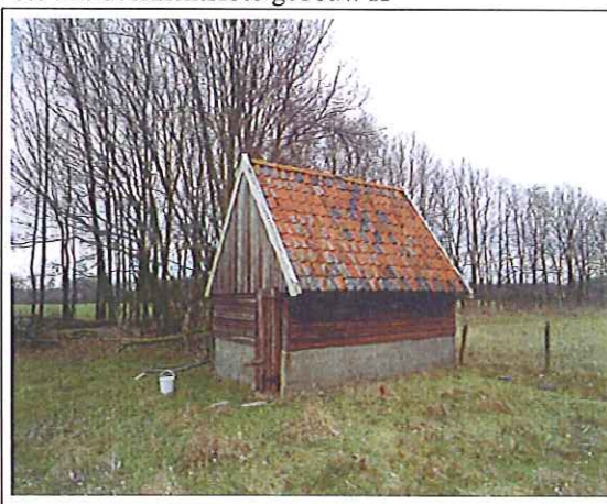
Foto 22: overzichtsfoto gebouw H
