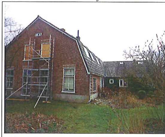
Foto 2: overzichtsfoto buitenzijde woonhuis nr. 11 en 11a
