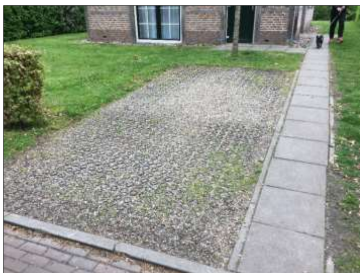
Afbeelding 31: Voorbeeld van een halfverharding met een honingraatfundering;
