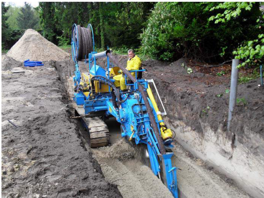
Figuur 4.2 Aanleg drainage
