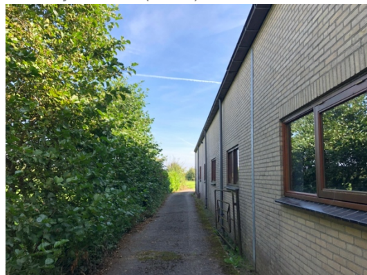
Zijkant schuur (noordwest)
