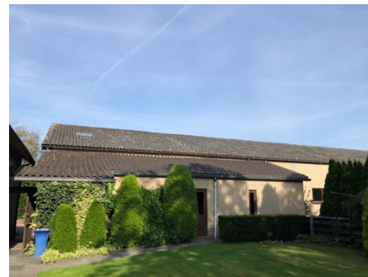
Zijkant schuur met aanbouw (zuidoost)
