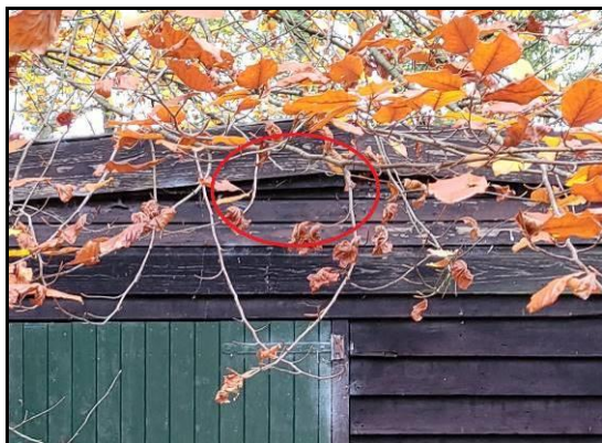
Afbeelding 5: Opening tussen de houten platen
