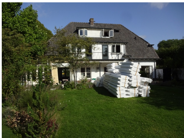
achterzijde woning Rosariumlaan 47
