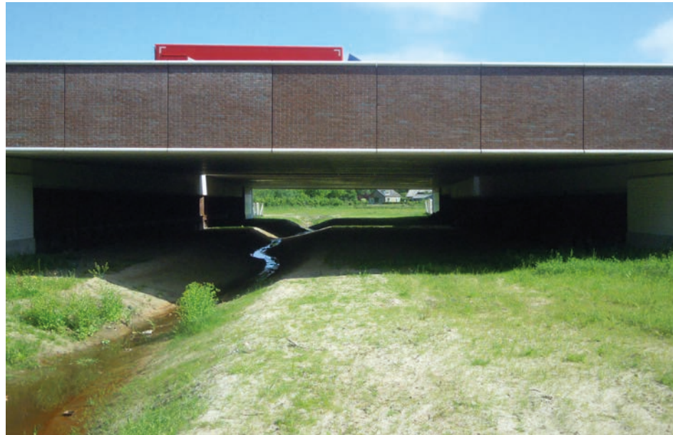
Faunapassage Hoge Woerd, zicht naar het zuiden
