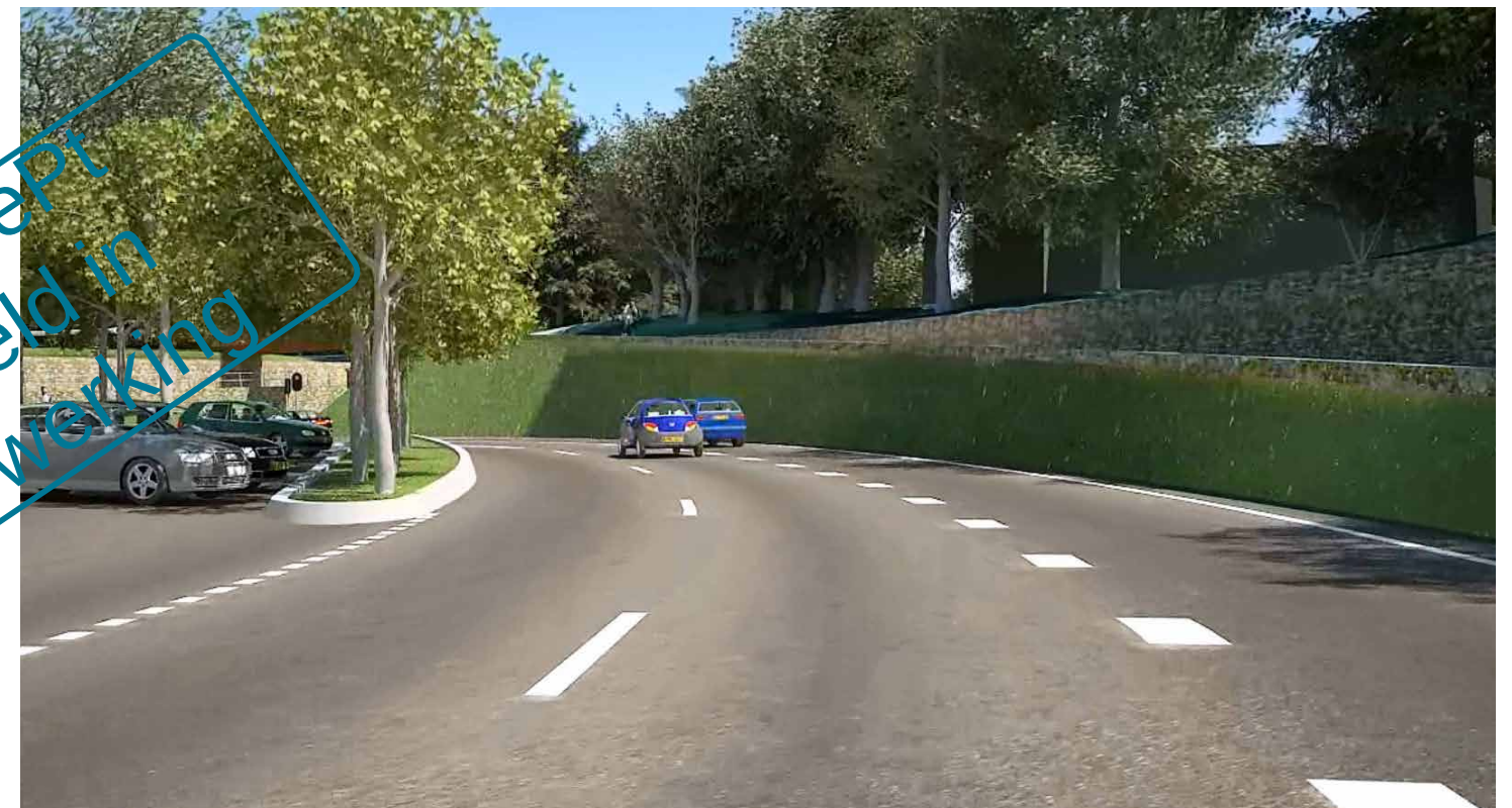
Beeld vanaf Stationsweg/oversteekplaats voetganger/fiets: begroeid talud, fietspad met daarboven keerwand natuursteen
