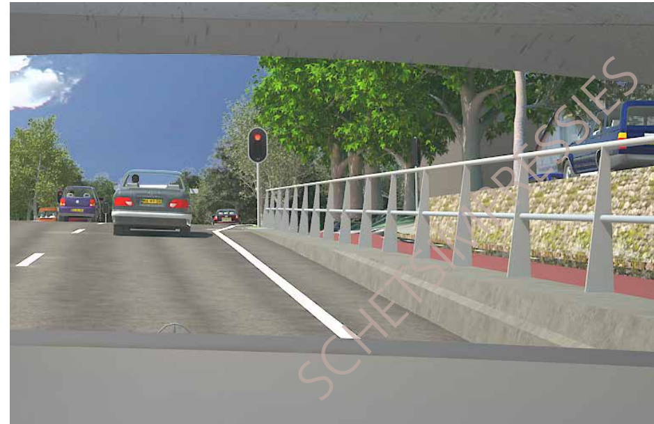
Zicht van verkeer komend vanuit onderdoorgang richting Zeist, overzicht op in-uitrit Hoofdstraat 9 ontbreekt.
