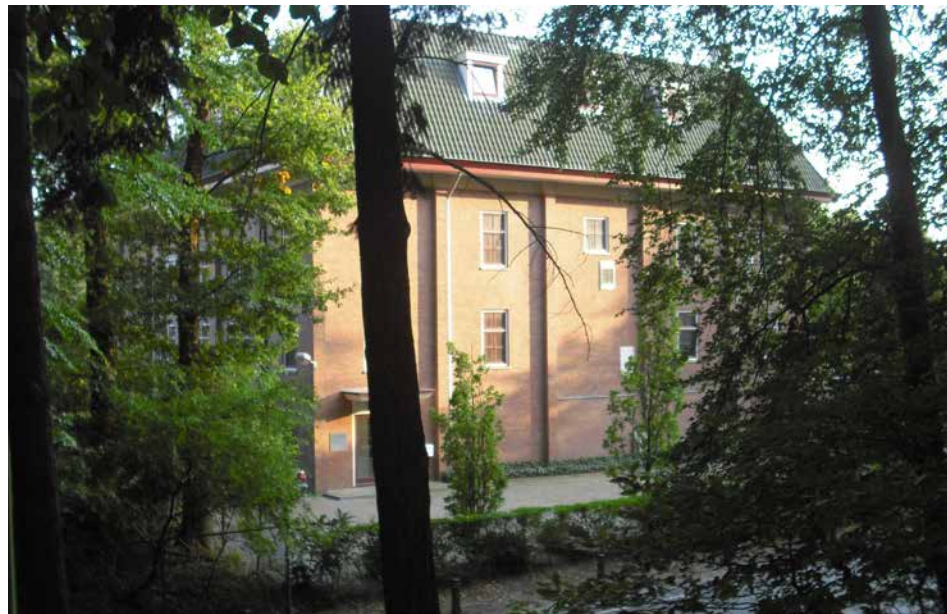
De bunker aan de Breullaan
