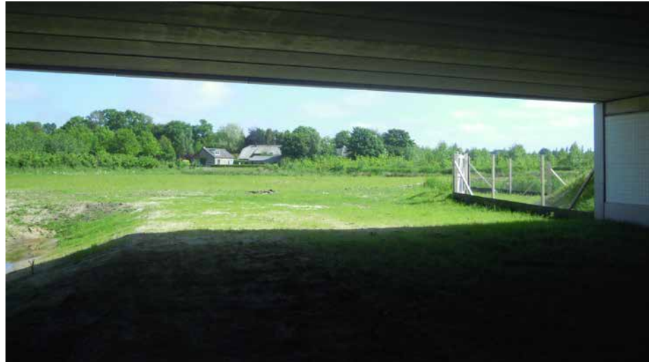
Faunapassage Hoge Woerd, zicht naar het noorden
