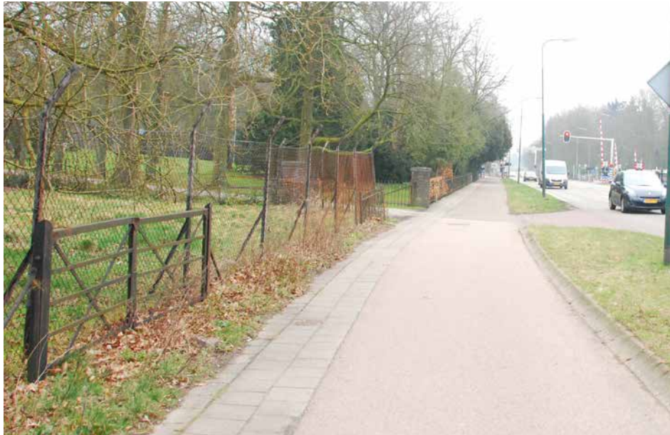
Het hekwerk van Bornia, dat vervangen wordt voor een spijlenhekwerk.
