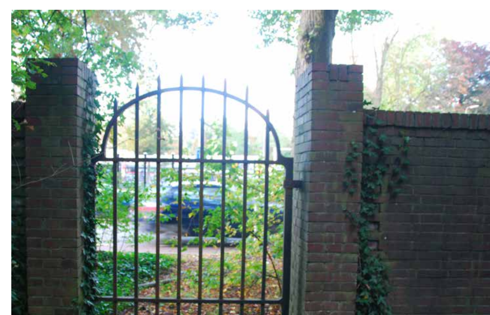
Bestaand hekwerk, niet in gebruik van entree
