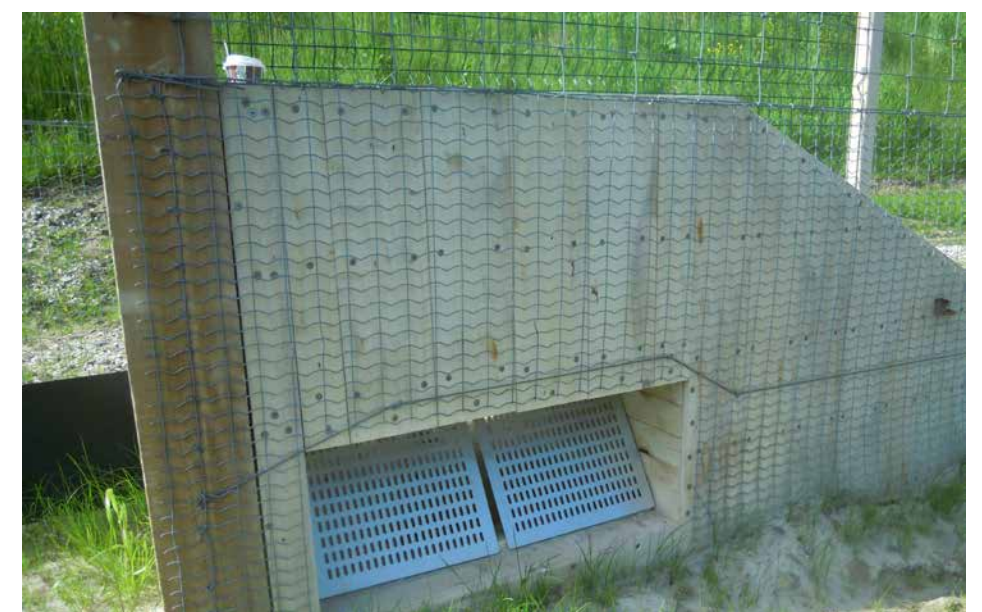
Voorziening voor ingesloten reën en dassen
