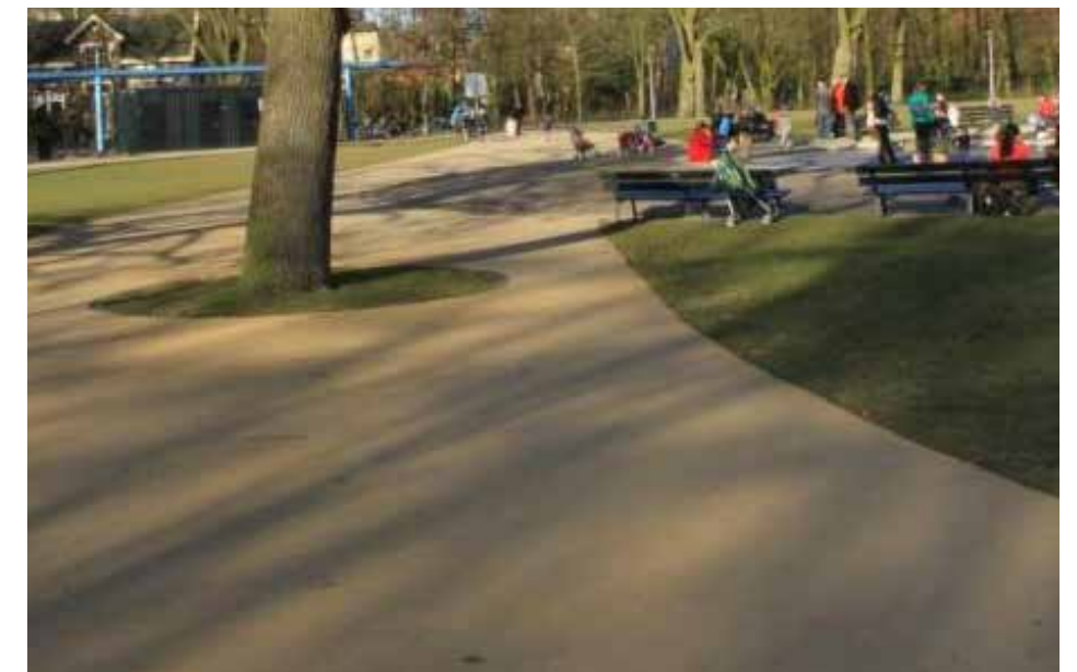
Grindpave, geel zandkleurig asfalt (DuraVermeer), Vondelpark Amsterdam
