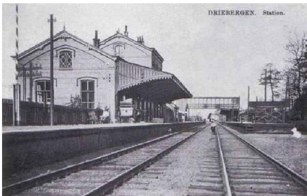
Afbeelding 14 Rechts achter op de foto (moeilijk zichtbaar) de perronoverkapping en de loopbrug op eilandperron, rond 1900
