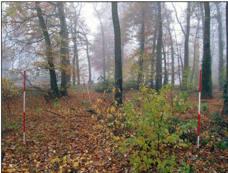
Het toekomstige wegtracé is in het veld uitgezet, om de best mogelijke route door de bosstrook te vinden.
