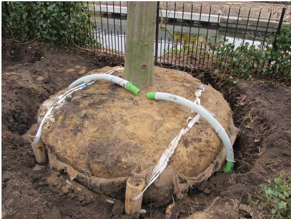
Ondergrondse verankering met beluchtingsdrain
