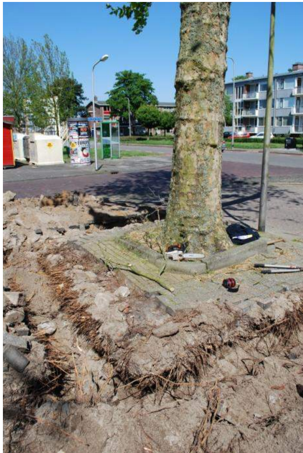
Een plataan waarvan de kluit aan drie kanten is afgestoken in het kader van de voorbereiding van de verplanting.
