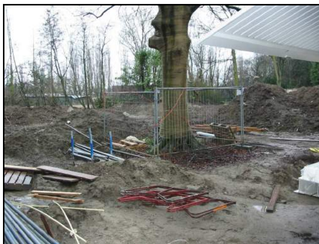
Een volledig verreden en verdichte groeiplaats: voor een volwassen beuk vaak de start van de aftakelingsfase.
