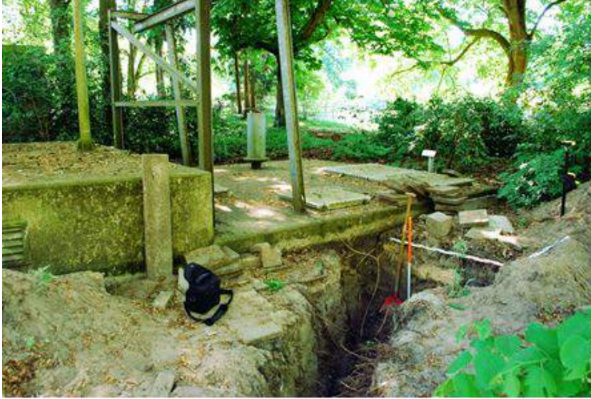
Afbeelding 7 Punt 12 bij betonnen constructie
