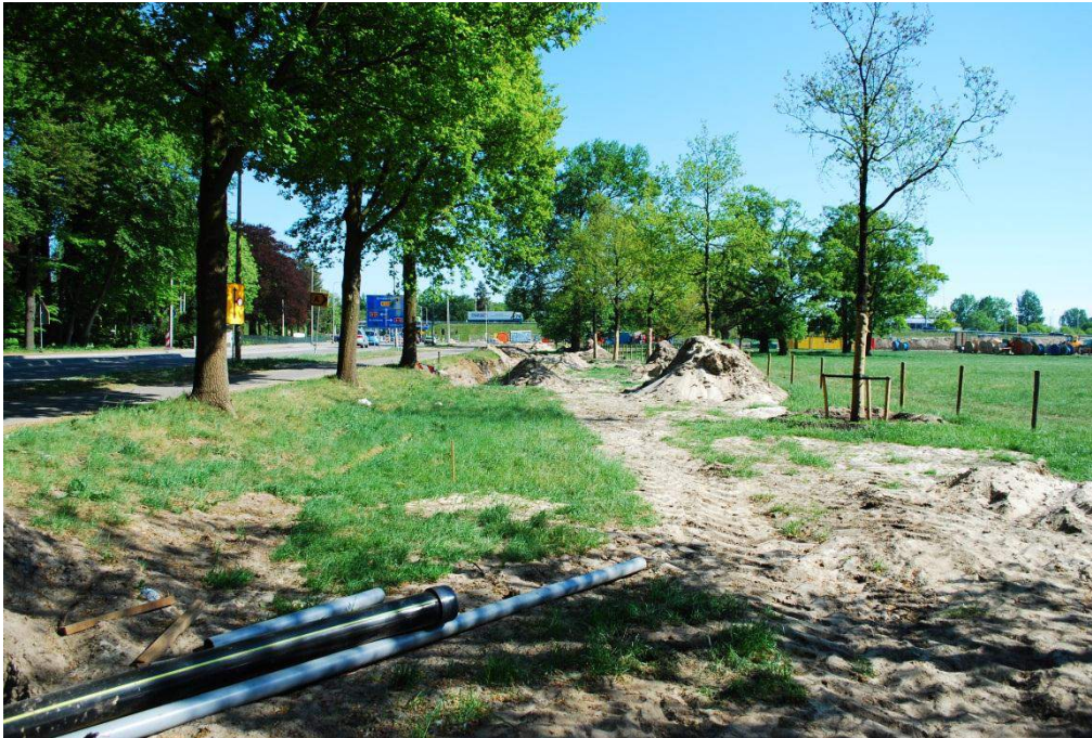
Afbeelding 9 Omgeving bij punt 13 met links de Hoofdstraat en in het midden op de achtergrond, de aangetroffen leidingsleuf.
