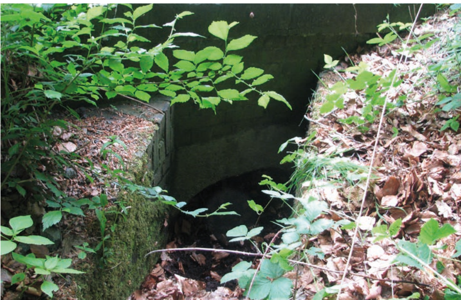
Huidige duiker onder spoor. Door verbreding spoor kan deze niet blijven.
