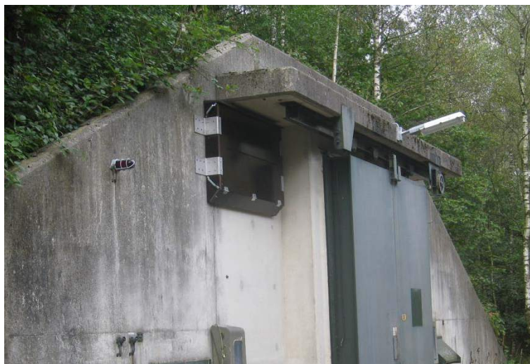
Afmeting kast: 1,80m breed, 1 meter hoog; deze is geplaatst op vliegbasis Soesterberg
