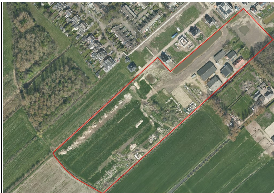
Luchtfoto huidige situatie, naar het noorden gezien
