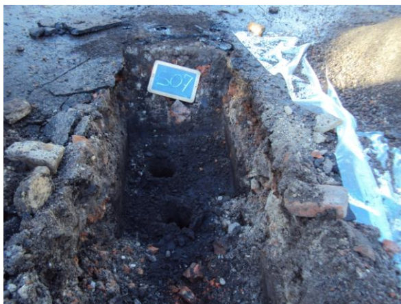
Foto Asbestinspectiesleuf S07
