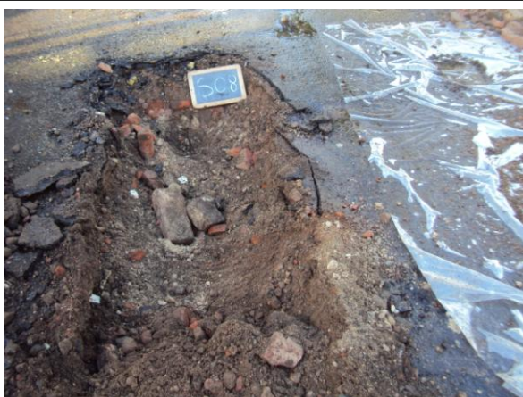
Foto Asbestinspectiesleuf S08
