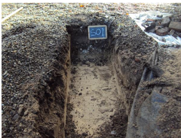
Foto Asbestinspectiesleuf S01
