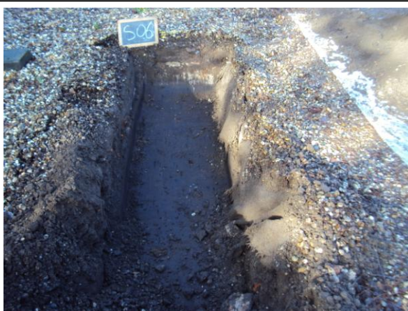
Foto Asbestinspectiesleuf S06
