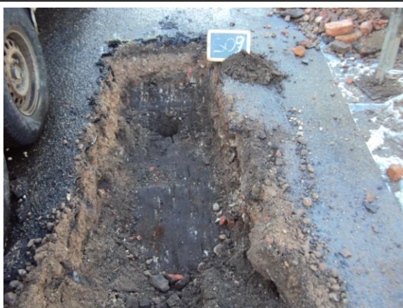
Foto Asbestinspectiesleuf S09
