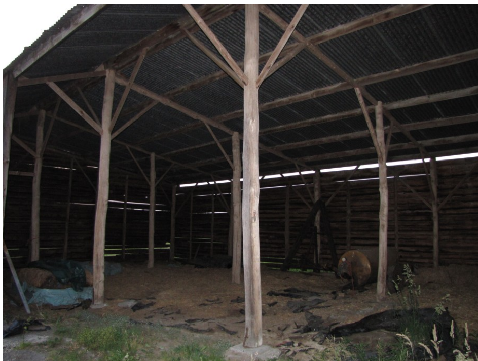
Figuur 12. Interieur van een van de opstallen.
