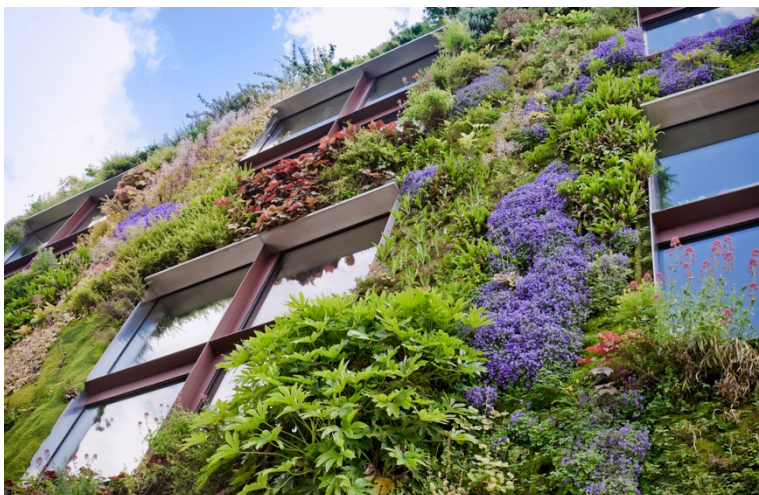
Voorbeeld van een groengevel
