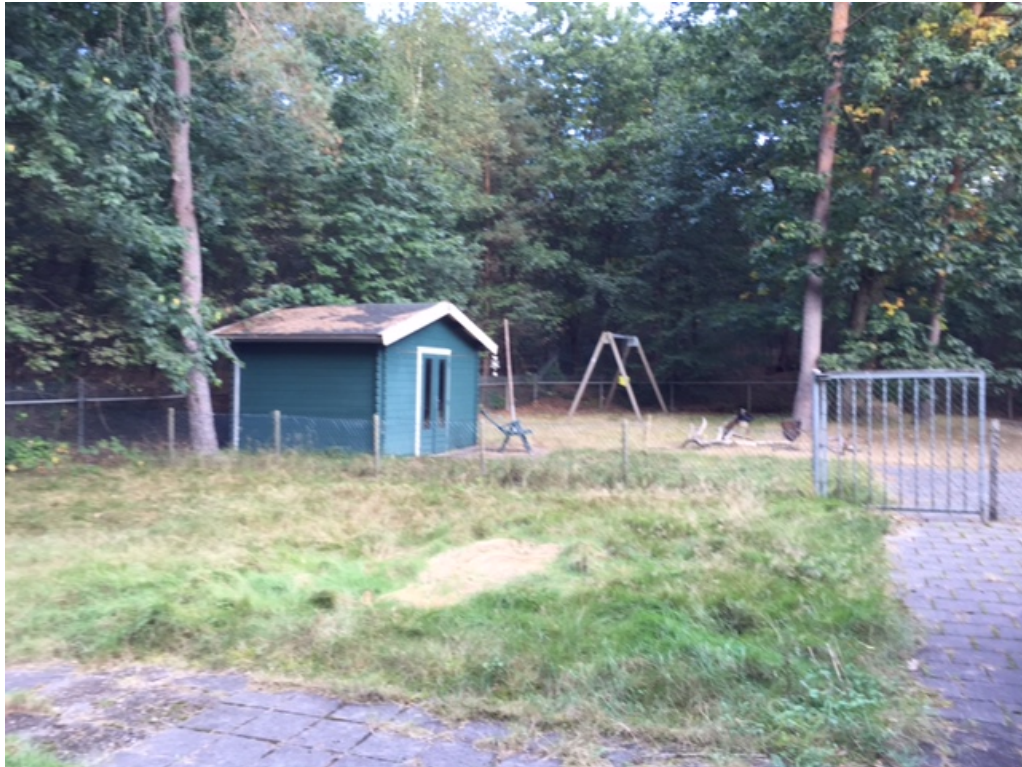
Figuur 3 Rondom het zorgcomplex is sprake van diverse aanbouwen en bijgebouwen die worden gesloopt.
