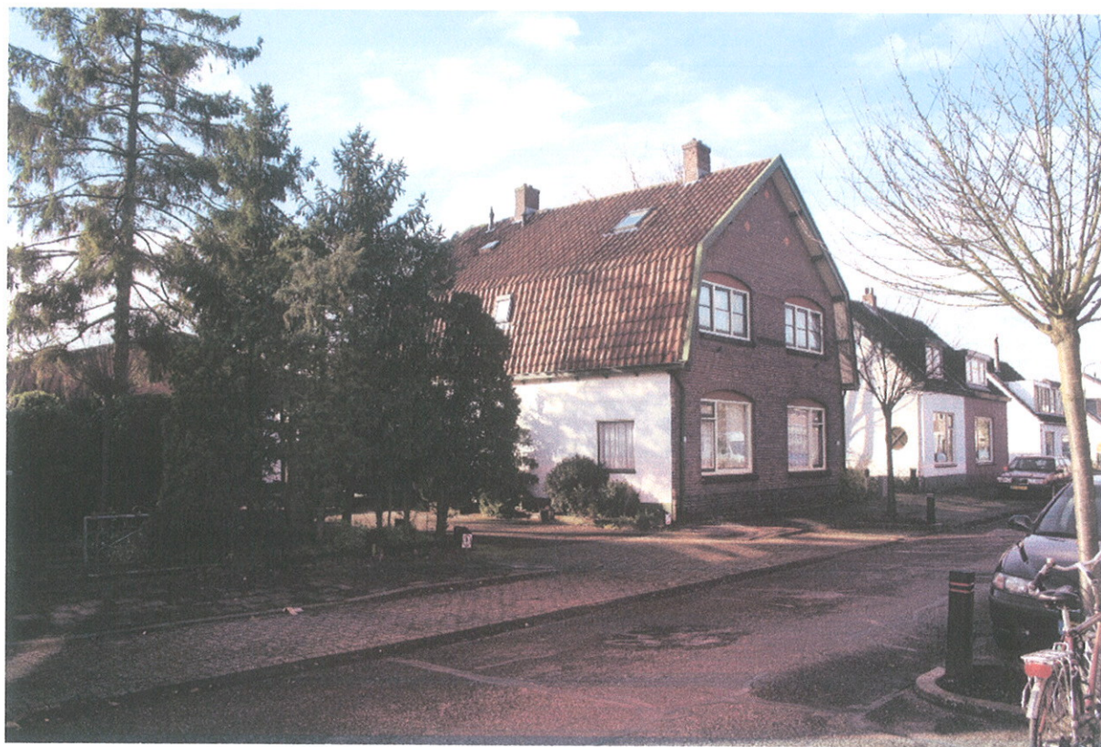
Huidige situatie van Heemstrstraat 12 a/b
