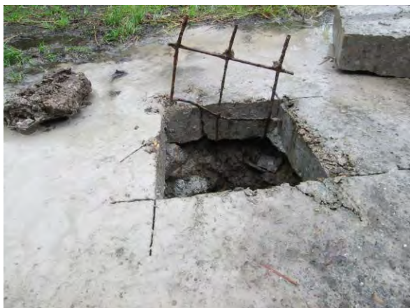
Foto 7: Ingezaagd beton ter plaatse van gat 6
