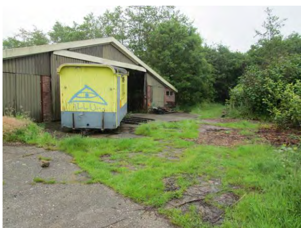
Foto 5: Achter (zuidoost-) zijde onderzoekslocatie
