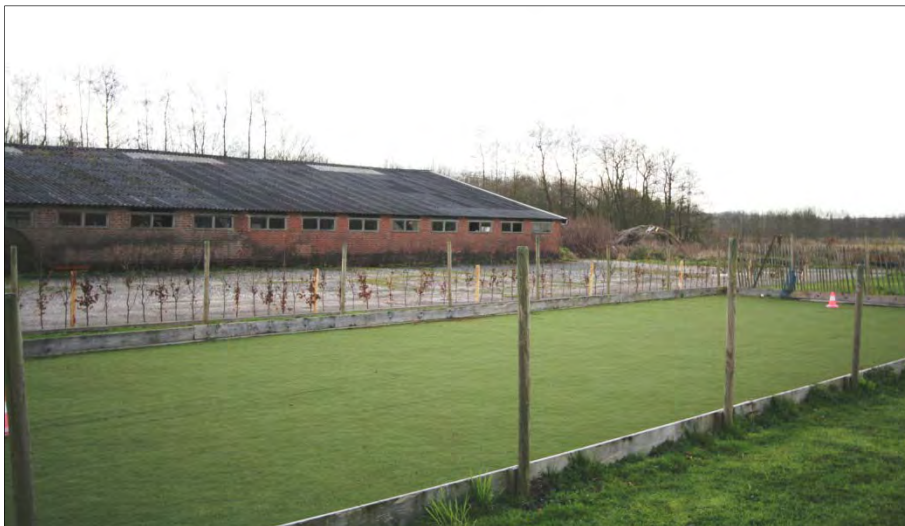
Situatie plangebied: te slopen doorloopstal
