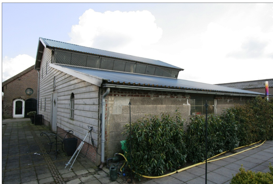
Te slopen melkstal achter woongedeelte
