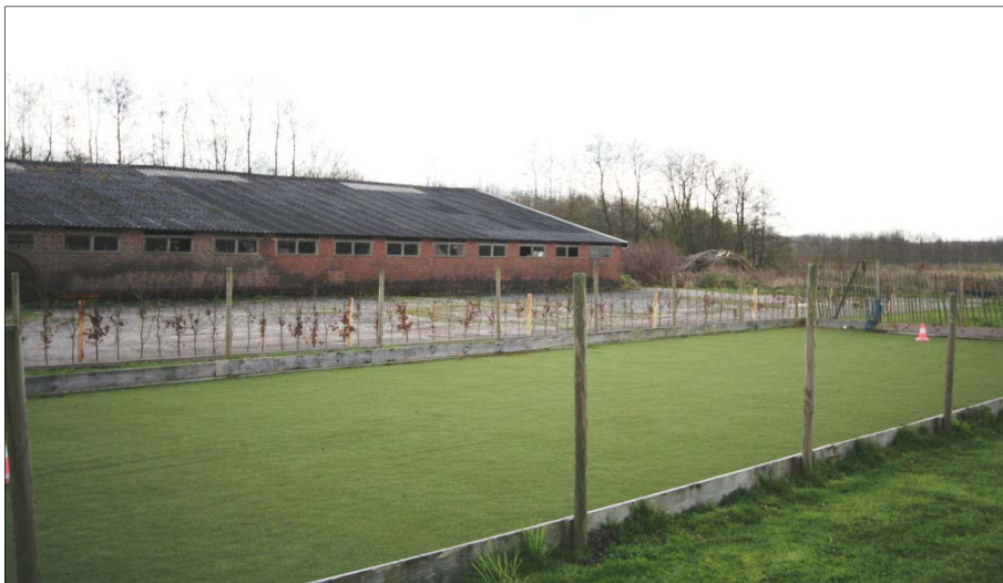
Situatie plangebied: te slopen doorloopstal
