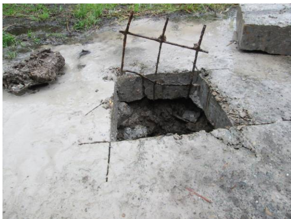
Foto 7: Ingezaagd beton ter plaatse van gat 6
