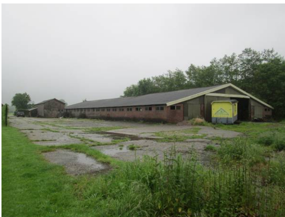
Foto 4: Zuidwestzijde onderzoekslocatie (vanuit het zuiden)
