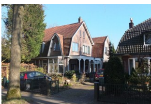
Bosstraat uitbouw oostzijde
