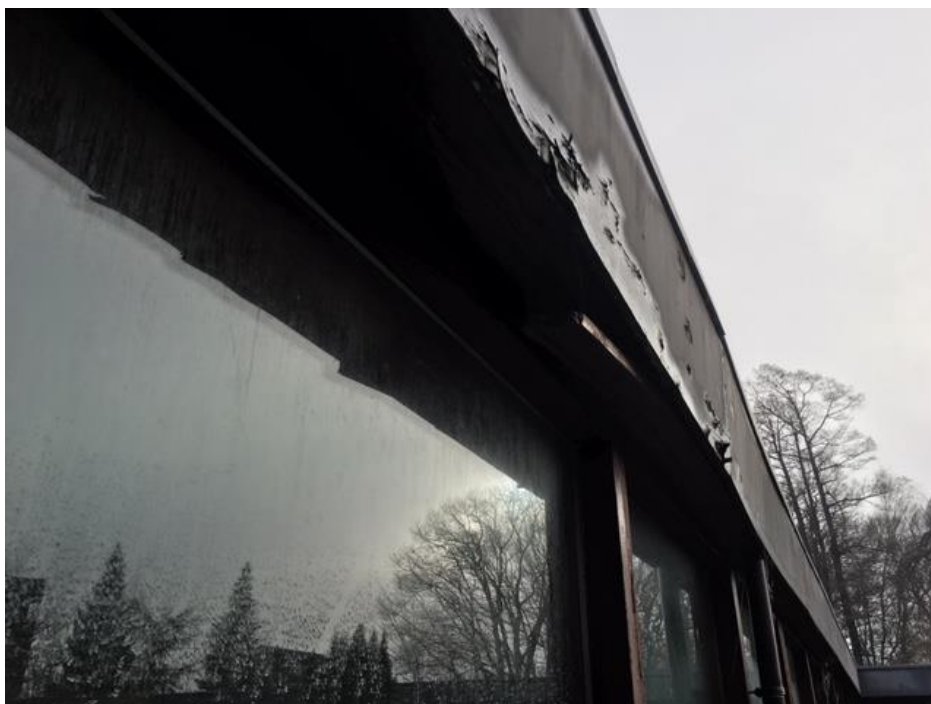
Figuur 4.5. loszittende delen bakgoot carré.
