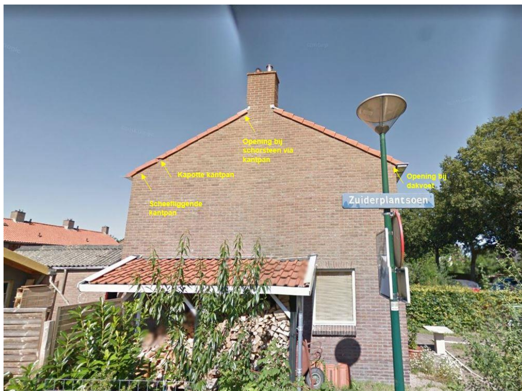
Figuur 2 Voorbeelden van geschikte openingen die toegankelijk zijn voor vleermuizen in de woning aan de Akkerweg 134 (bron foto: GoogleStreetview).
